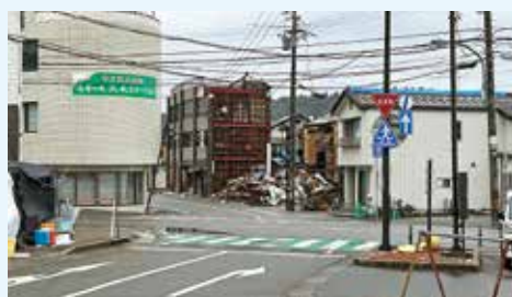
▲傾いたり崩れたり崩壊した建物があちこちに…
